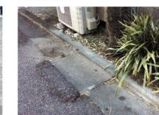
中台地域センター近くの、道路脇の植樹がアスファルトを押し上げ段差が発生。車の往来時にショックが大きいとご相談を頂き補修しました。道路補修の相談はよく頂きます。
